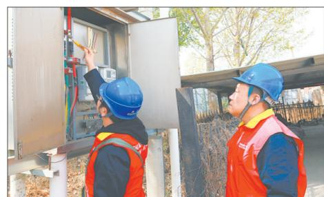
国网大厂供电公司结合近期电网负荷、设备负载和雷雨天气多发等情况,切实做好用户需求响应工作,积极开展排查治理专项行动,在用电高峰时段抽检台区电压情况,并对设备建立跟踪检查记录,保障大负荷期间客户电力系统的可靠运行。 武全铭 摄
