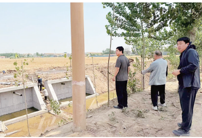
正在建设中的河南疃镇扬水点。 曲周县水利局供图
