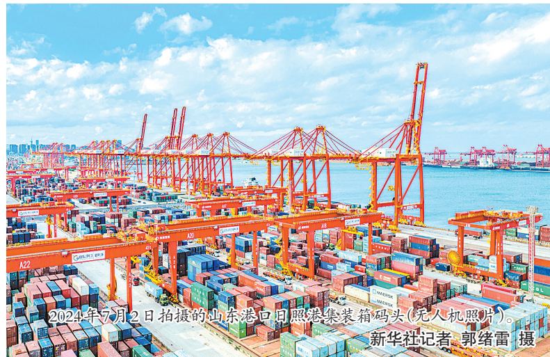
2024年7月2日拍摄的山东港口日照港集装箱码头(无人机照片)。新华社记者 郭绪雷 摄
