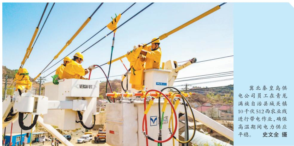
冀北秦皇岛供电公司员工在青龙满族自治县城关镇10千伏512西农业线进行带电作业,确保高温期间电力供应平稳。 史文全 摄
