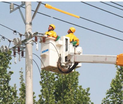
随着夏季的到来,广宗县南寺郭葡萄小镇也即将迎来特色果蔬丰收季。为保障小镇大棚种植用电,广宗县供电公司开展带电接引作业,缩短停电时间,用实际行动助力乡村特色产业。崔力升 摄
