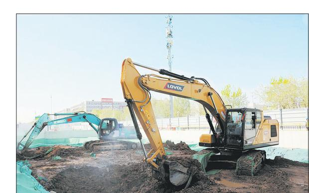
4月16日,在石家庄地铁5号线宫北路站建设现场,施工人员紧张忙碌,伴随着大型挖掘机的轰鸣声,宫北路站基坑开挖,石家庄地铁5号线一期工程刷新“进度条”。宫北路站是5号线一期工程的起点站,车站全长415.9米,标准段宽度19.7米,为地下两层岛式车站,设2座风亭4个出入口。本报记者 刘朋朋 摄
