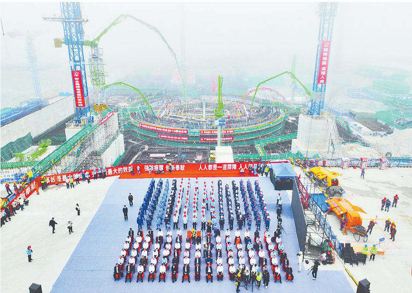
2月22日,中核集团漳州核电二期工程“华龙一号”3号机组浇筑核岛第一罐混凝土浇筑现场(无人机照片)。 新华社发
