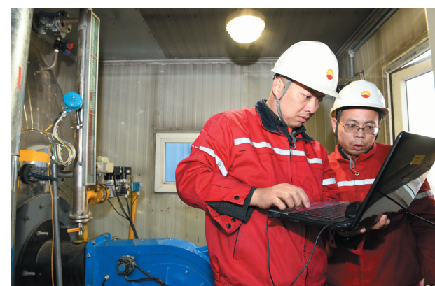
新年伊始,华北油田采油一厂积极探索自主运维管理模式,提高数字化运维服务质量,做到油水井一般故障当天处置不过夜,复杂故障48小时解决,有效提升了设备运行完好率和使用率。图为1月17日,该厂运维人员员工在处置加热炉熄火报警故障。 赵利庆 摄
