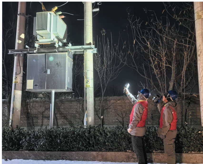
为保证输电线路安全可靠运行,近日,国网三河市供电公司制定专项计划,安排运维人员利用红外测温仪对辖区内多个重点线路进行夜间特巡和测温,及时消除设备缺陷,保障居民温暖过冬。边玉玲 王一 摄
