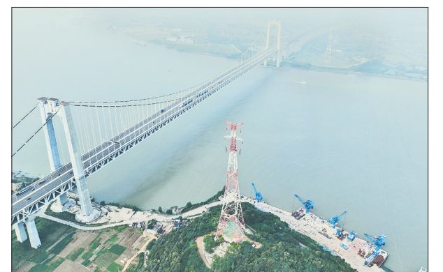
9月26日拍摄的扬州-镇江±200千伏直流输电工程长江大跨越段导线更换作业现场(无人机照片)。
