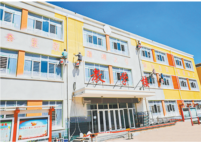
在永清县第四中学,施工人员正在粉刷教学楼墙面。
