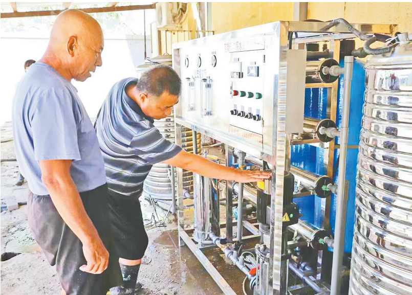
在涿州市中心敬老院，工作人员正在对新安装的净水设备进行调试。
