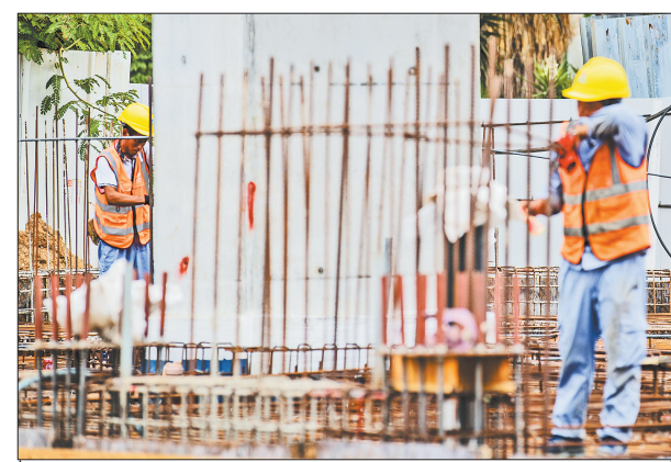
8月14日,建设人员在以色列特拉维夫轻轨线G3-4标段工程施工现场作业。由中国电力建设集团有限公司(中国电建)承建的以色列特拉维夫轻轨线G3-4标段工程于2022年4月开始施工,将建设一座轻轨大桥和一座建筑面积2400平方米的轻轨地面车站。建成后,绿线将连通特拉维夫市中心与南部区域,进一步缓解市民出行压力。
