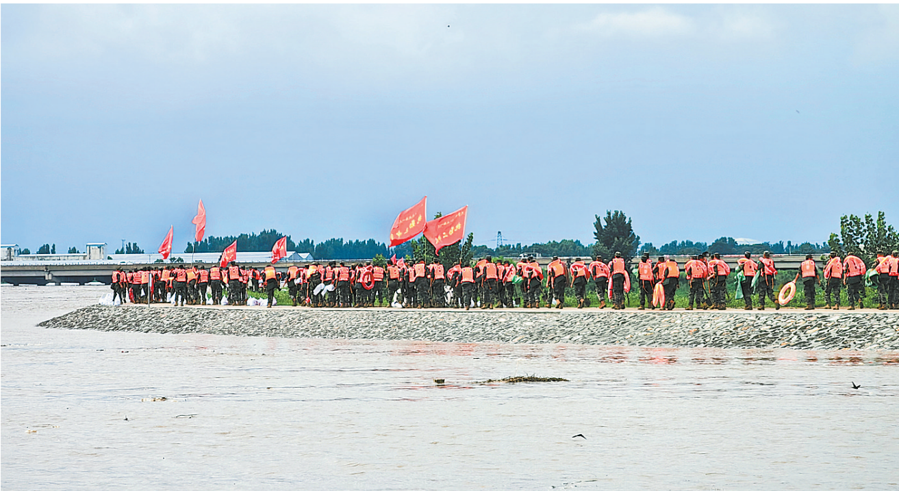
7月31日,邢台市南和区民兵应急抢险分队和武警官兵一道在南澧河大堤上固堤排险。
