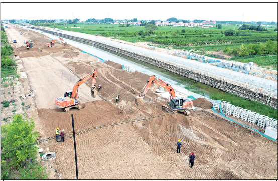
当前正值防汛关键期,大城县积极实施环境水系生态环境综合治理工程,不断加强河道综合治理,通过开展河道清淤、岸坡防护、修建堤坝、渠道巡查、防汛物资盘点核等工作,增强防洪能力。图为工人在大城县环境水系工程施工现场作业。
