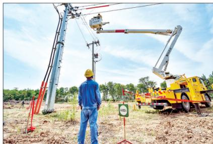
近日，国网衡水市桃城区供电公司不断提升配网带电作业水平，及时为新上400千伏安变压器解决电源问题，减少了附近8个村庄近1000户居民的停电感知。图为国网衡水市桃城区供电公司带电作业人员在10千伏5909北八村线路129号杆进行不停电接引。
