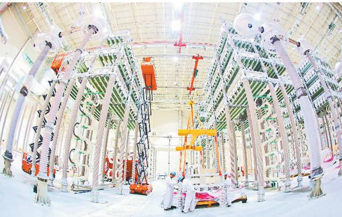
张北柔性直流电网工程换流阀安装现场。
