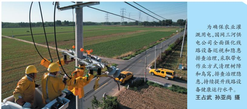
为确保农业灌溉用电,国网三河供电公司全面强化线路设备巡视和隐患排查治理,采取带电作业方式清理树障和鸟窝,排查治理隐患,持续提升线路设备健康运行水平。
