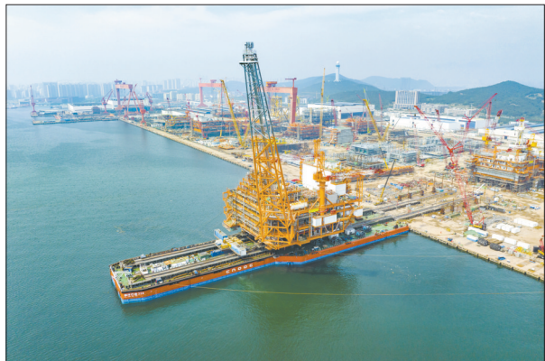
这是7月10日在山东省青岛市拍摄的渤中19-6凝析气田一期项目中心平台装船作业现场。
