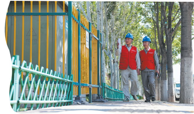
国网张家口供电公司电缆运检中心员工巡视设备。 伴建忠 摄 电、错峰用电。 电网迎峰度夏,安全是关键。该公司将持续优化迎峰度夏保供电方案,强化安全用电宣
