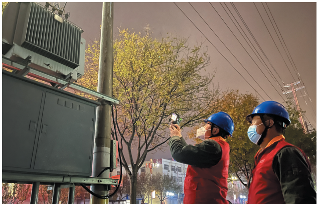
7月5日20时,国网景县供电公司线路特巡人员化身“夜行侠”到县城景安大街等区域,对城区负荷较重线路进行红外测温工作。该公司通过加强夜间线路特巡力度,迎战近日持续的高温天气,守护百姓清凉度夏。 吕浩云 冯钊 摄
