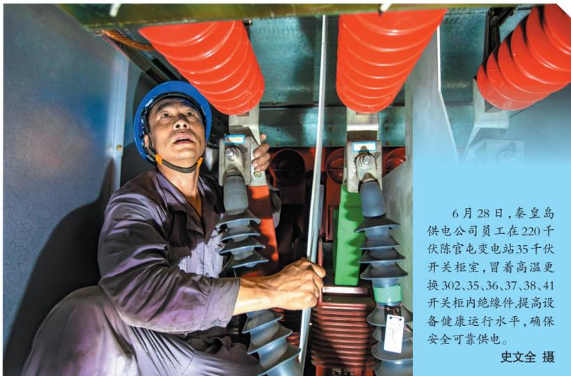
6月28日,秦皇岛供电公司员工在220千伏陈官屯变电站35千伏开关柜室,冒着高温更换302、35、36、37、38、41开关柜内绝缘件,提高设备健康运行水平,确保安全可靠供电。史文全 摄
