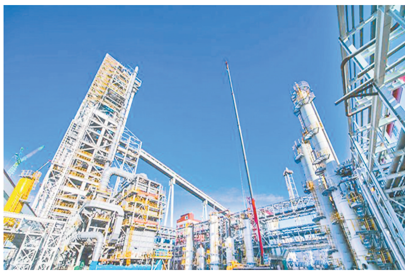
河钢集团120万吨氢冶金示范工程现场。
