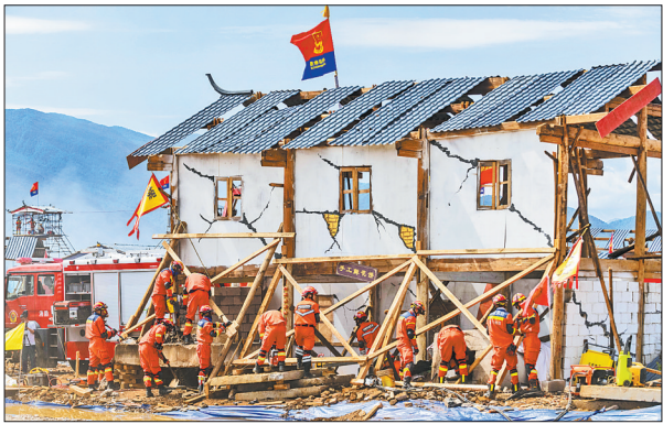
5月16日,参演人员在丽江演习现场对受损建筑物进行排除加固。当日,国务院抗震救灾指挥部办公室、应急管理部、云南省人民政府在云南丽江等地联合举行高山峡谷地区地震灾害空地一体化联合救援演习,代号“应急使命·2023”。新华社记者 陈欣波 摄
