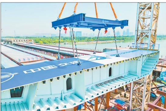
5月15日上午，石家庄市复兴大街市政化改造项目滹沱河特大桥主桥首片钢箱梁成功吊装，标志着滹沱河特大桥主桥上部结构作业面正式展开，工程顺利迈入新阶段。
