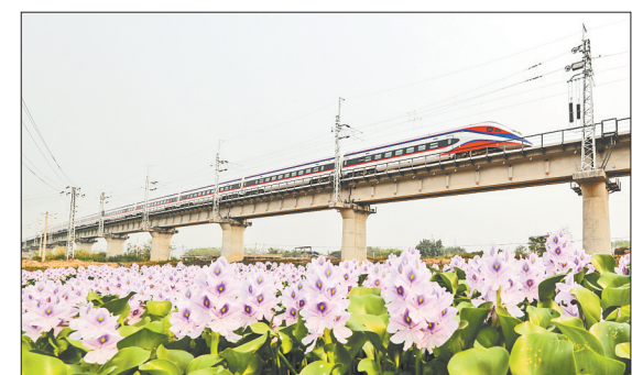
4月13日,从老挝万象站驶出的D888次“澜沧号”列车行驶在云南省西双版纳州境内的中老铁路橄榄坝特大桥上。当日,中老铁路开行国际旅客列车,昆明至万象间可实现乘火车当日通达。
