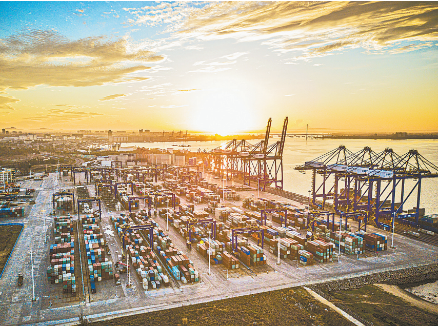
这是2021年5月26日在海南洋浦经济开发区拍摄的洋浦国际集装箱码头。
