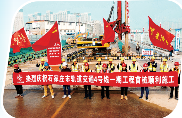
石家庄地铁 4 号线一期工程的石铜路站建设现场。张超 摄
