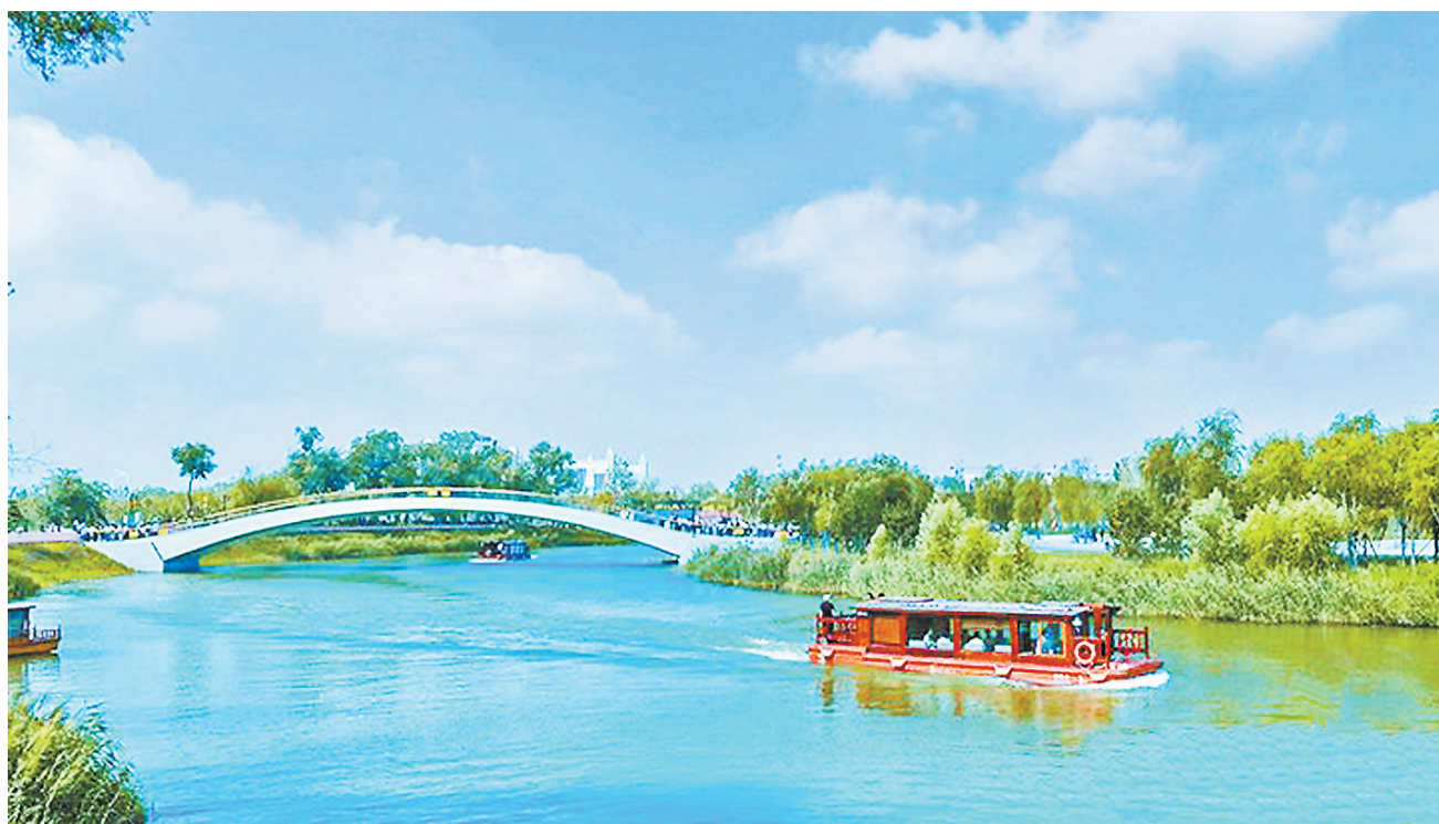
京杭大运河沧州中心城区段实现旅游通航。
