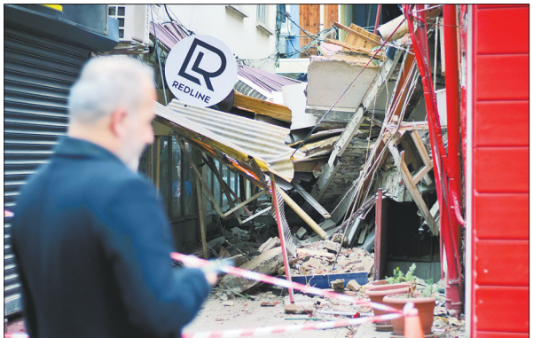
这是 11 月 23 日在土耳其迪兹杰拍摄的被地震摧毁的房屋。土耳其灾难和应急管理局 23 日发布消息说,该国西北部迪兹杰省当天凌晨发生 5.9 级地震,目前已造成 22 人受伤。 新华社发(穆斯塔法·卡亚摄)
