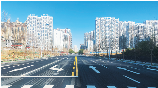
近日,定州市明月街南延道路通车。明月街南延项目全长495米,设双向6车道。道路通车后,将进一步完善城市路网结构,拉大城市框架,缩短周边居民出行距离,方便城南近40万群众出行。 赵珍珍 摄
