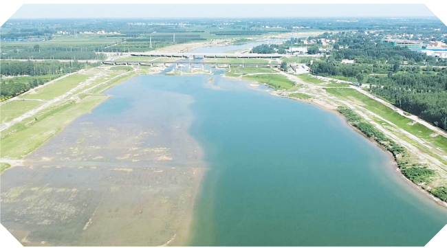
水系治理京广铁路段。 鲁丽华 摄
