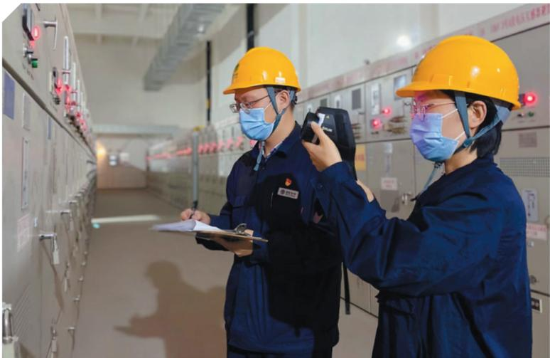
取暖期来临,国网石家庄供电公司成立服务队,深入供暖企业开展上门走访,全面检查企业配电箱、备用电源、压力泵、水泵等设施,对存在安全隐患的设备提出整改意见,主动提供技术支持和服务,沟通用电需求,征求意见建议,确保供暖企业用电设备“零缺陷”运行。图为国网石家庄供电公司变电运维人员在220千伏仓丰变电站对10千伏开关柜柜体进行红外测温。王静 摄
