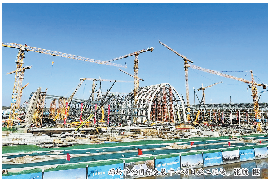
廊坊临空国际会展中心项目施工现场。张航 摄
