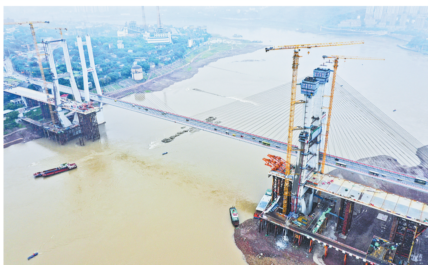
这是9月27日拍摄的重庆轨道交通18号线李家沱长江复线桥施工作业现场(无人机照片)。 新华社记者 王全超 摄
