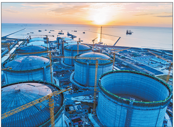
9月22日,中建电力建设有限公司承建的中海油盐城“绿能港”项目一期扩建工程10号储罐完成升顶任务,标志着整个项目所有储罐均顺利升顶,主体结构基本完成,建成后将成为国内规模最大的液化天然气储备基地。“绿能港”项目包含一期工程4座22万立方米液化天然气储罐和一期扩建工程6座27万立方米液化天然气储罐,总罐容达250万立方米。
