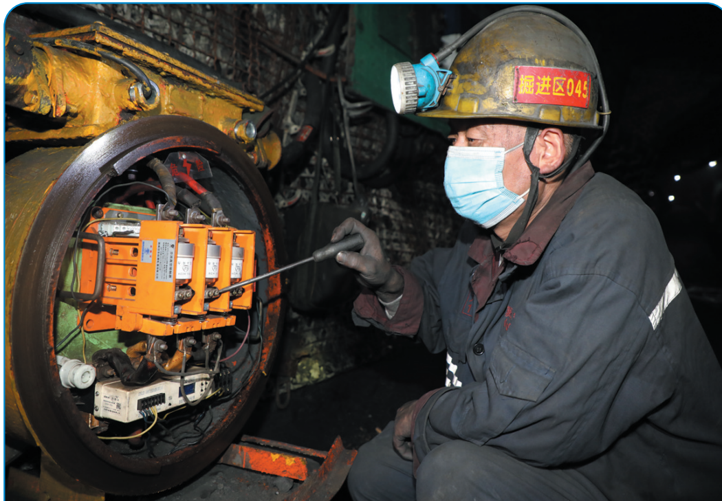
三季度以来,冀中能源峰峰集团万年矿加大对井下各类设备隐患排查力度,确保实现高效运转。图为该矿职工正在检查机电设备。杨鹤 安玉平 摄
