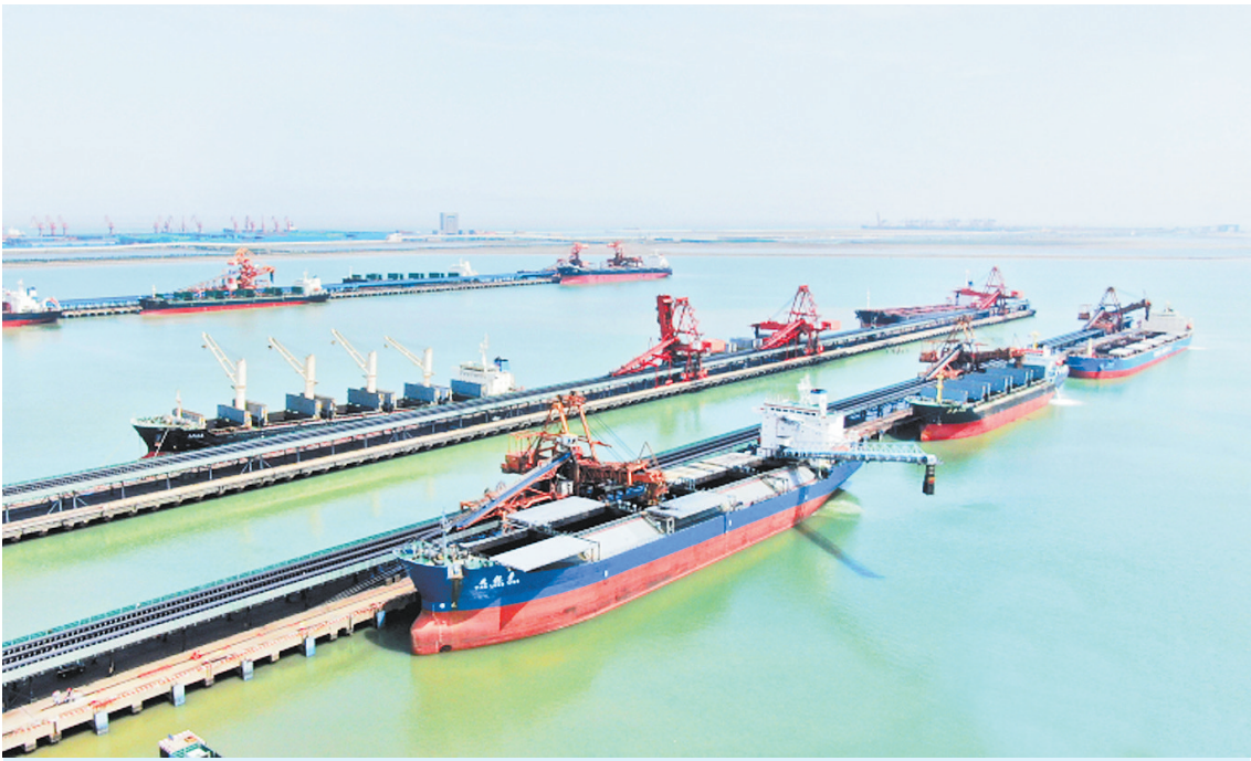
7月13日,装船机为停靠黄骅港的船舶装运电煤。当下,正值电力供应迎峰度夏高峰,为满足发电厂用煤需求,作为我国重要的电煤输出港,入夏以来,黄骅港不断增强煤炭运输和储备能力,运用5G智能装船系统提升电煤装船效率,科学安排船舶进出港,确保电煤稳定供应。
