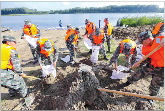
近日,大厂回族自治县组织开展2022年防汛抢险演练,通过堤防加固、管涌抢护、水上巡逻、无人机搜寻、水上救援等科目演练,提高防汛应急处置能力和群众避险自救能力。图为抢险人员进行管涌抢护科目演练。 何赛 摄
