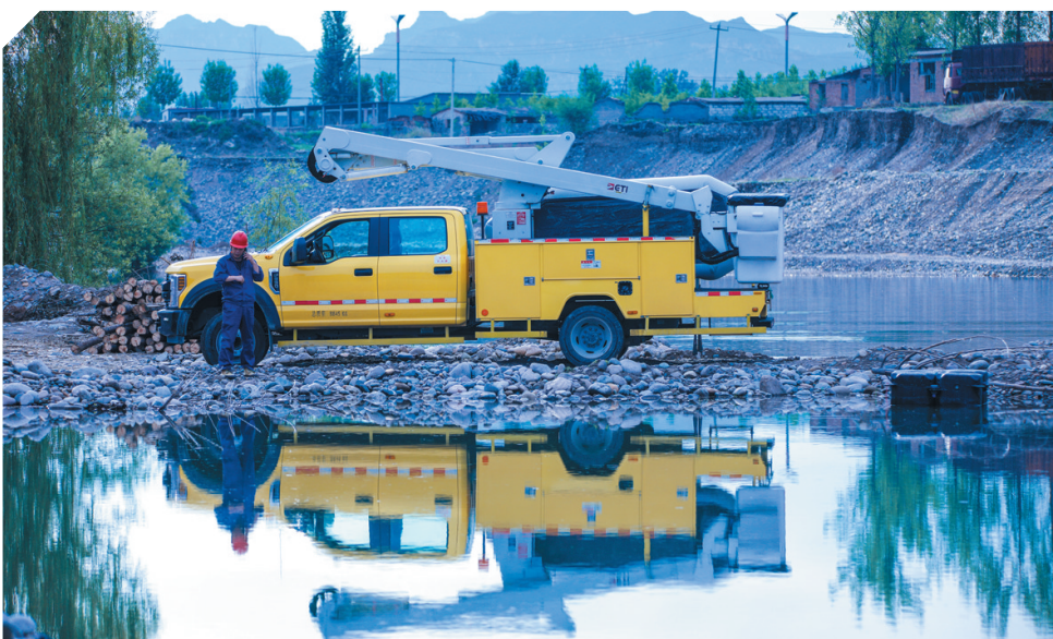
万全供电公司工作人员在户外进行电力作业。
