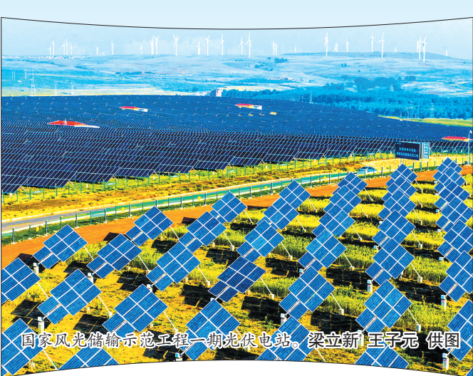
国家风光储输示范工程一期光伏电站。
