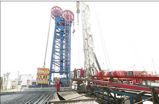
5月份以来,冀东油田井下作业公司紧紧围绕月度生产任务目标,不断加快生产运行节奏,提高作业效率,保证重点井施工进度,为油田油气生产提供有力保障。图为该公司员工正在作业施工。 杨军 陈会永 摄
