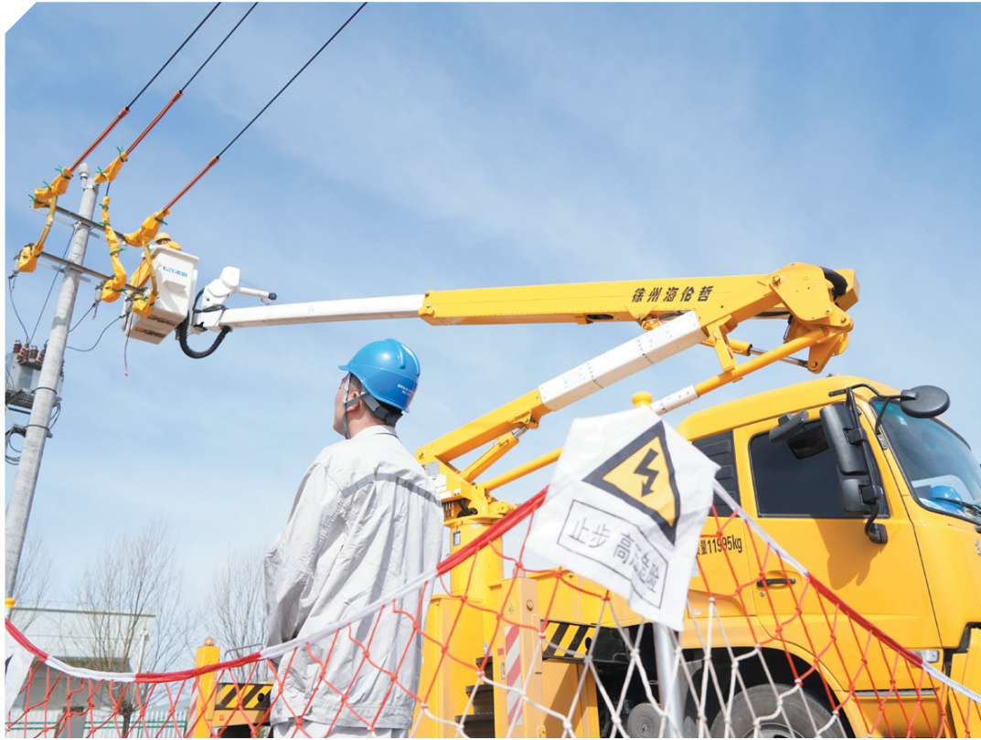
4月11日,张家口万全区供电公司运维检修部工作人员在10千伏工东一线公交公司支线1号处开展带电接引工作,拉开了春季检修的帷幕。此次春检,有效保障了电网安全稳定运行,为春夏安全可靠供电打下了良好基础。 刘慧娟 摄
