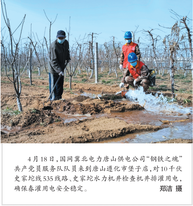
4月18日,国网冀北电力唐山供电公司“钢铁之魂”共产党员服务队队员来到唐山遵化市堡子店,对10千伏史家坨线535线路、史家坨水力机井检查机井排灌用电,确保春灌用电安全稳定。 郑洁 摄
