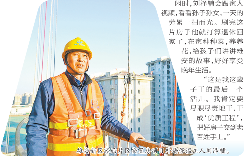
雄安新区容西片区安置房项目外墙保温工人刘泽辅。
