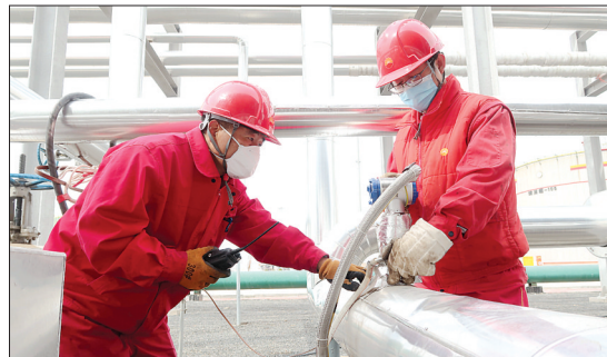
冀东油田油气集输公司一手抓疫情防控、一手抓油水气处理,党员带头,干部员工坚守岗位、履职尽责,全力以赴确保各项生产经营工作平稳、有序运行。图为员工在排查隐患。 杨军 王翔 摄
