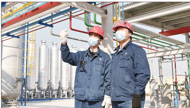
近日,两名工人在位于任丘市的中国石油华北石化公司副产氢提纯装置区巡检。自2021年12月6日为“相约北京”测试赛提供清洁能源起,一直到2022年3月10日,中国石油华北石化公司共为北京冬奥会和冬残奥会供应高纯氢190车,合计56789公斤,为助力绿色冬奥提供有力保障。
