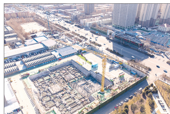
作为石家庄市“拥河发展”的起步区、示范区、引领区,日前,太平河城市片区已完成了规划设计方案的评审工作,建设工作进入了新阶段。图为位于太平河南岸广场南侧的太平河城市片区展示中心建设工地一派繁忙景象。康义涵 摄
