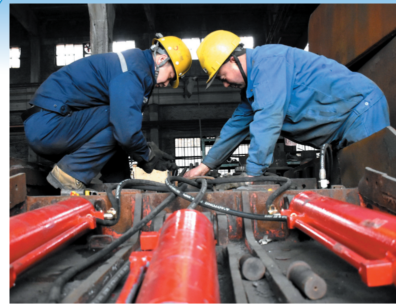
2月23日,冀中能源邯矿集团邯二庄矿职工在自行安装综采支架顶镐。新春伊始,该矿工会号召全矿干部职工牢固树立“过紧日子”的思想,加大自修自制力度,全力推动内部设备调剂、自修、置换,加快材料设备内部循环,助推企业降本增效。程矿生 鲁道民 摄
