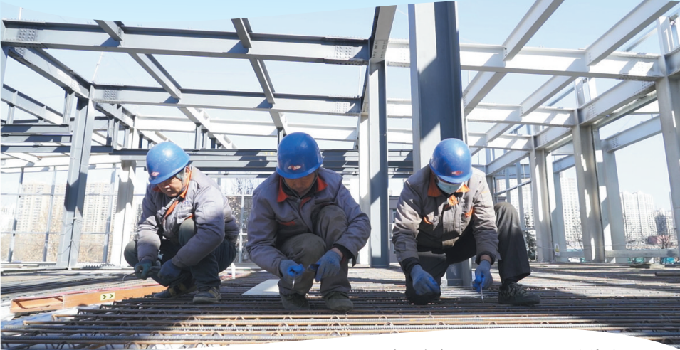
项目在建设者进行钢筋绑扎。康伟 摄
