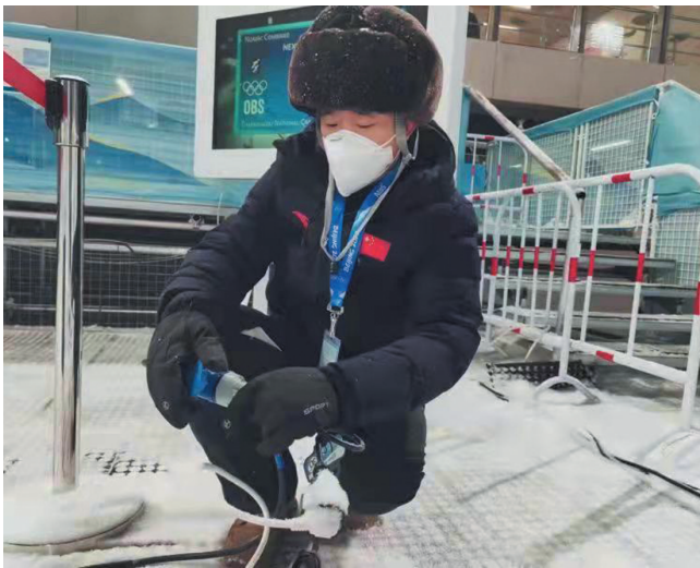
2月18日15时,崇礼国家越野滑雪中心刮着四五级的西北风,来自冀北廊坊供电公司冬奥电力保障团队的“90后”小伙儿许高鹏站在风雪中,正在对越野场馆计时计分点、现场展示大屏幕、灯光展示等用电设备及线路进行巡视。孙立娟 摄
