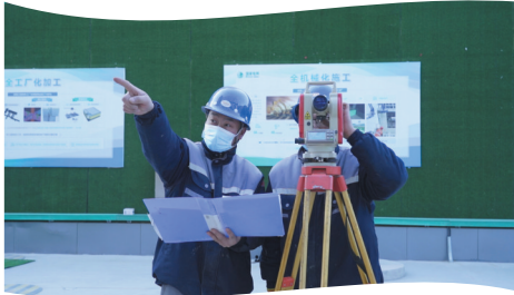
项目在建设者在裕翔站开展勘测。康伟 摄
