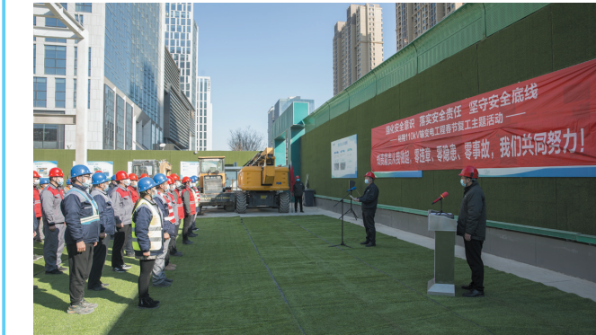
裕翔变电站工程开工仪式现场。康伟 摄
