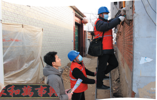
1月20日,新乐市供电公司员工在东王镇康兴村为返乡人员维修电表。 张蕾 摄
