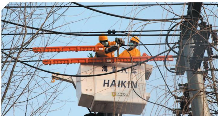
1月11日,武邑县供电公司运检部带电作业班对审坡供电所10千伏蒋屯547线路蒋屯村东支路供电设备进行带电接引。今年以来,该公司坚持“能带不停”的工作理念,深入推进带电作业,不断强化配网停电计划管控,切实提高电网可靠性。 鲁林锋 摄
