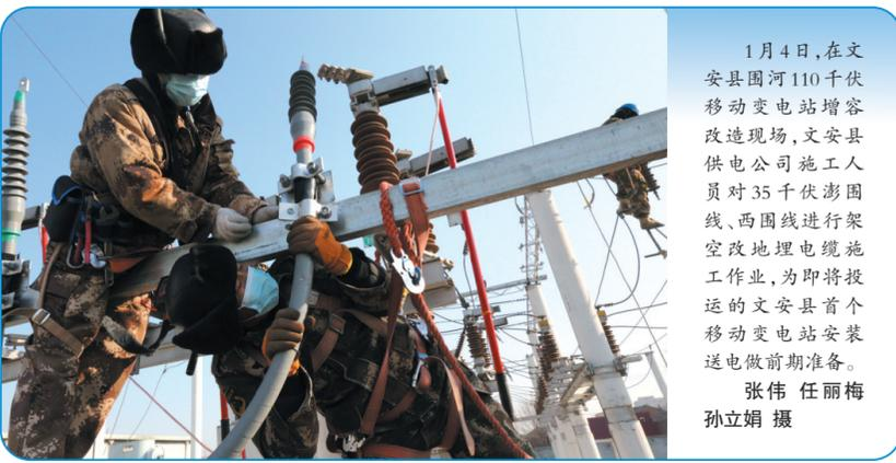
1月4日,在文安县围河110千伏移动变电站增容改造现场,文安县供电公司施工人员对35千伏游围线、西围线进行架空改地埋电缆施工作业,为即将投运的文安县首个移动变电站安装送电做前期准备。 张伟 任丽梅 孙立娟 摄
