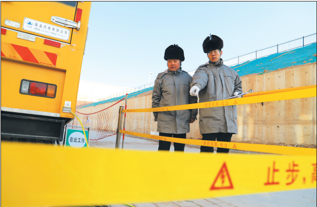
12月4日,第二次冬奥测试赛保电全面进入一级保电时段,万全供电公司服务保障队对涉奥用户开展现场巡视工作,重点对供电线路、高压配电室、变压器和主要供电设备及安全措施等开展巡视检查。刘慧娟 摄
